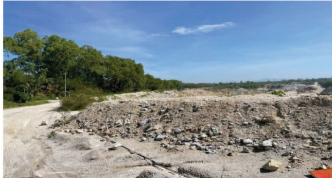
รูปที่ 2 คันทันดินบริเวณขอบบ่อเหมืองของโครงการ
